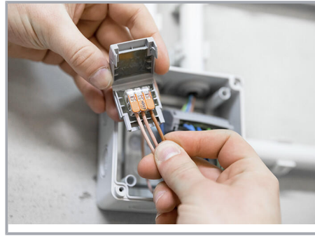
Verdrahtete Klemme in die Gelbox einlegen.
